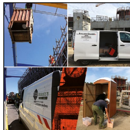
Location longue durée BTP Tout type de chantiers
